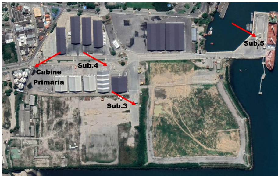
Figura 17. Localização da Cabine Primária e das Subestações
