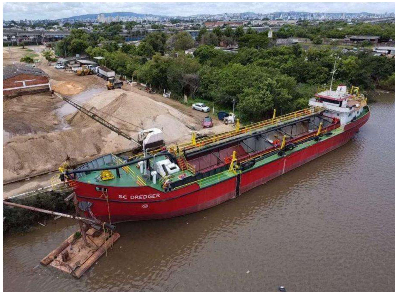
Foto disponível no Plano de Ataque da Obra de Dragagem de Manutenção.
