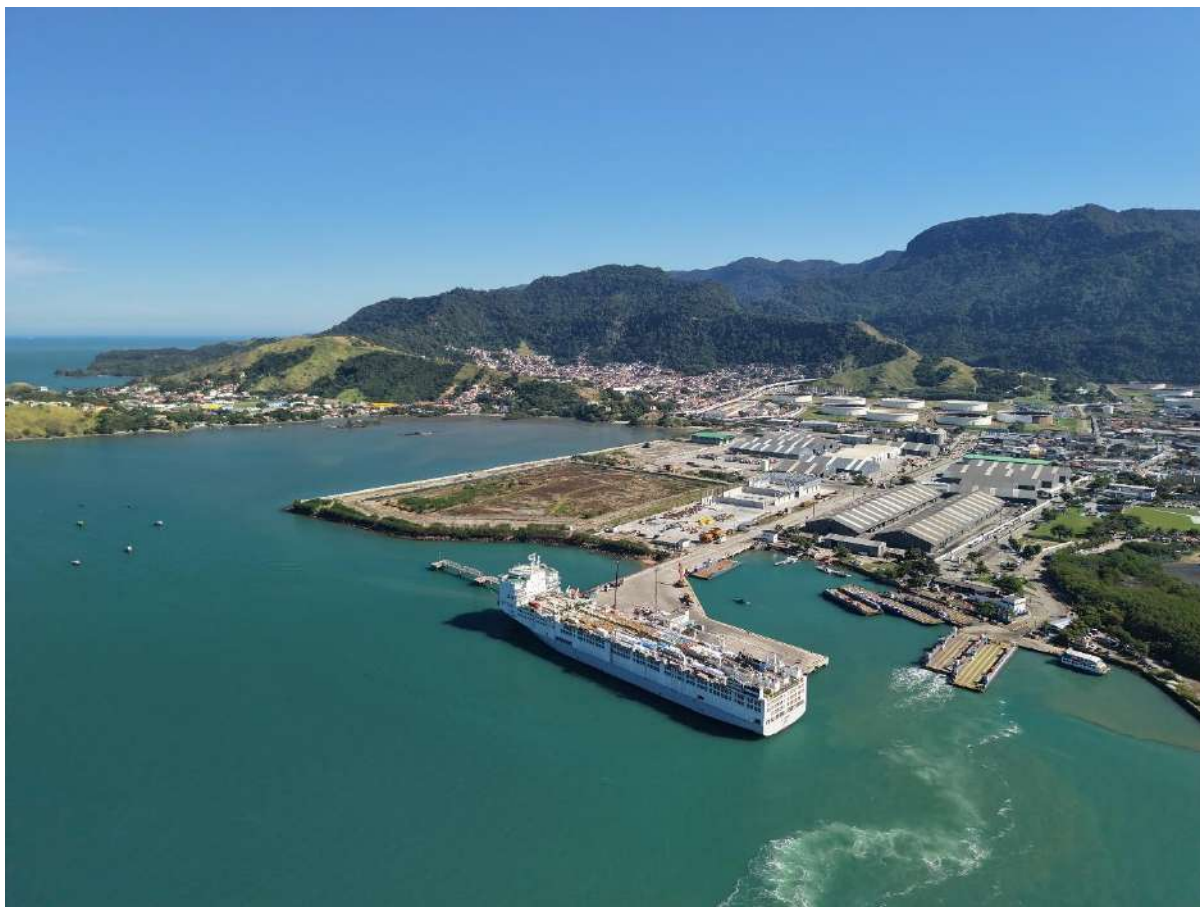
Figura 18 - Imagem aérea do Porto de São Sebastião feita com o drone, no dia 26 de junho de 2025.
