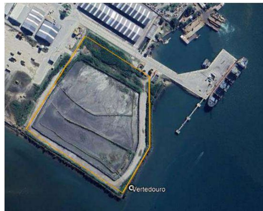
Área de disposição de sedimentos com os diques de contenção em seu perímetro (polígono em laranja). Plano de Ataque do Projeto de Dragagem.
