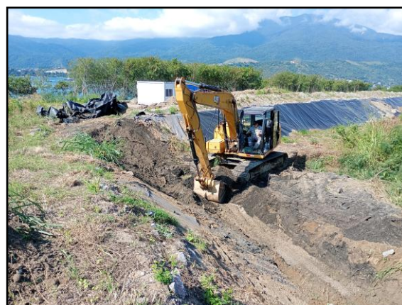
Foto 6: Recomposição da região interna dos taludes do dique.
