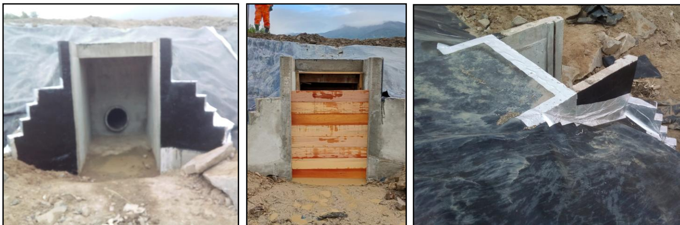
Foto 12: Construção do extravasor em alvenaria.
