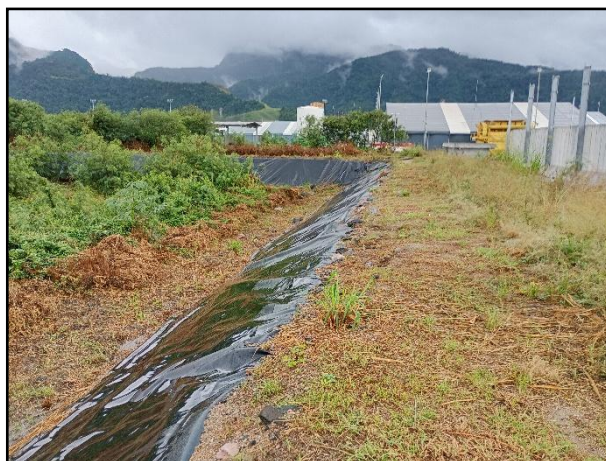
Foto 8: Mantas geotêxtil e geomembranas PEAD instaladas.
