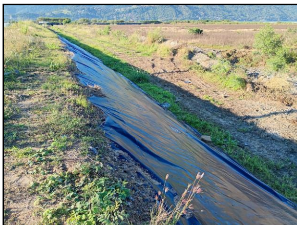
Foto 9: Mantas geotêxtil e geomembranas PEAD instaladas.
