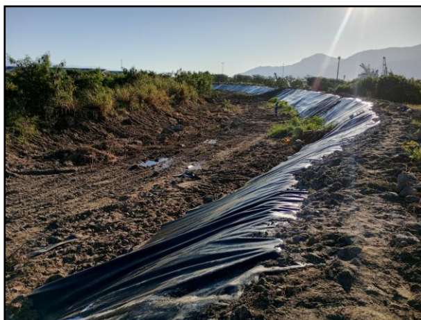
Foto 9: Mantas geotêxtil e geomembranas PEAD instaladas.
