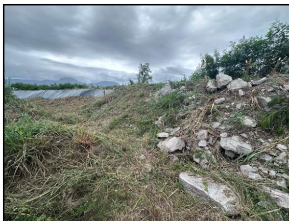
Foto 5: Regiões com geomembranas rasgadas ou ausentes.
