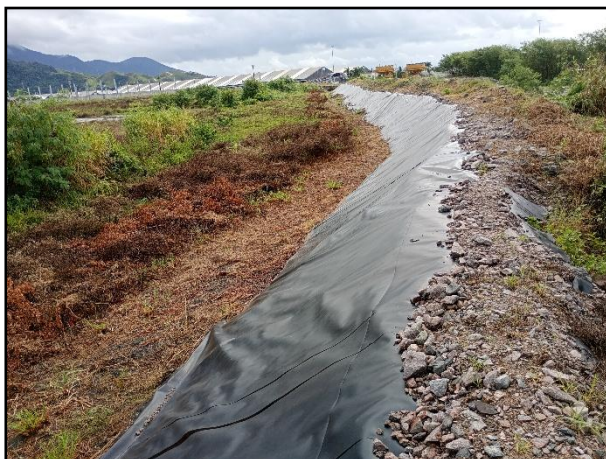
Foto 7: Mantas geotêxtil e geomembranas PEAD instaladas.
