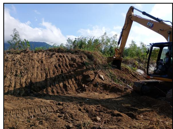
Foto 6: Recomposição da região interna dos taludes do dique.
