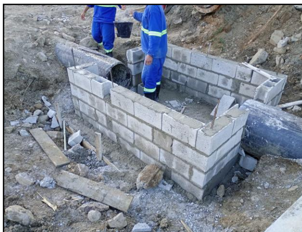
Foto 14: Processo de construção da caixa de passagem em alvenaria.
