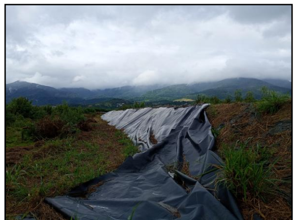
Foto 5: Regiões com geomembranas rasgadas ou ausentes.
