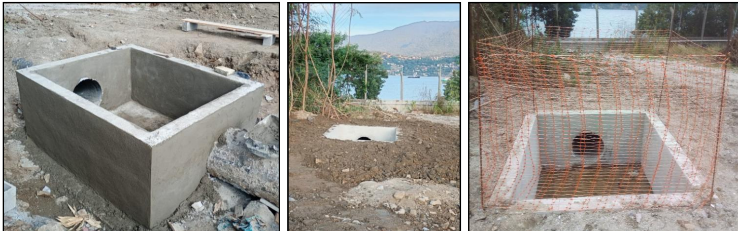
Foto 7: Construção da caixa de passagem em alvenaria.
