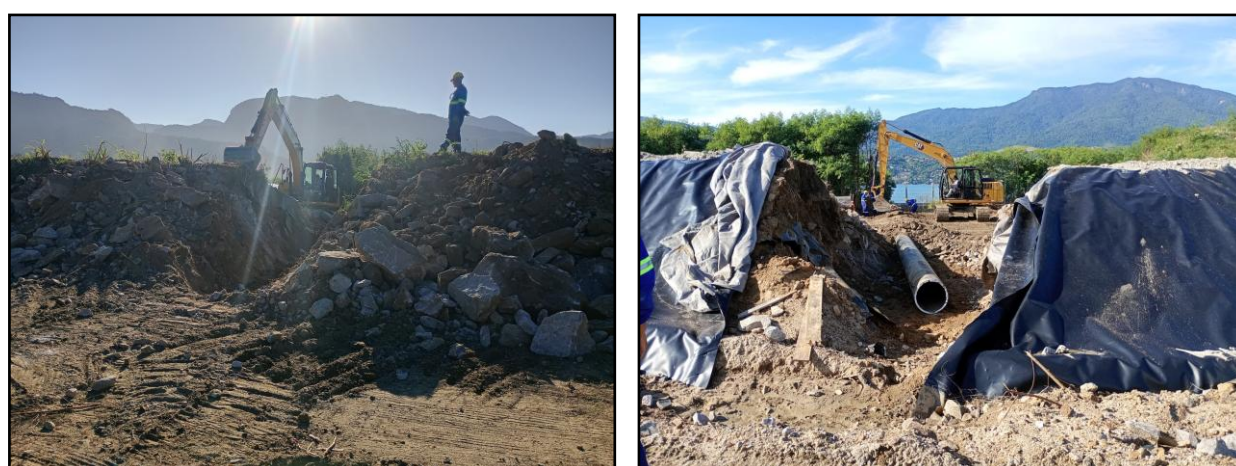
Foto 11: Abertura de talude e instalação de tubulação do extravasor.
