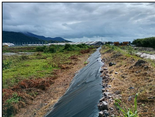
Foto 7: Mantas geotêxtil e geomembranas PEAD instaladas.
