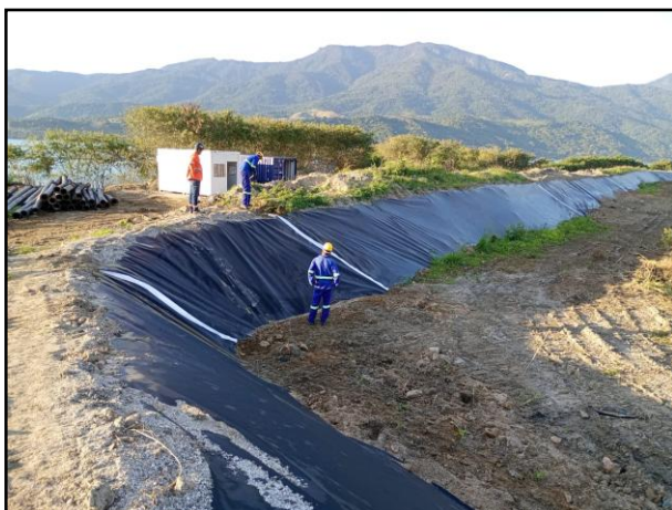
Foto 8: Mantas geotêxtil e geomembranas PEAD instaladas.
