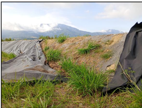
Foto 4: Regiões com geomembranas rasgadas ou ausentes.
