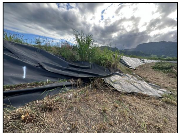
Foto 4: Regiões com geomembranas rasgadas ou ausentes.
