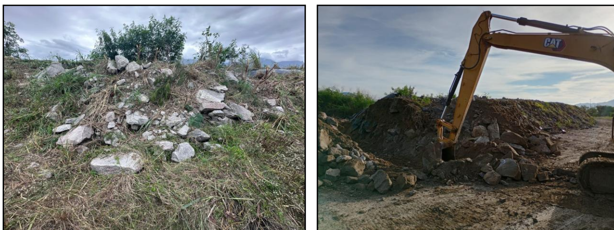
Foto 10: Região antes da construção do extravasor.
