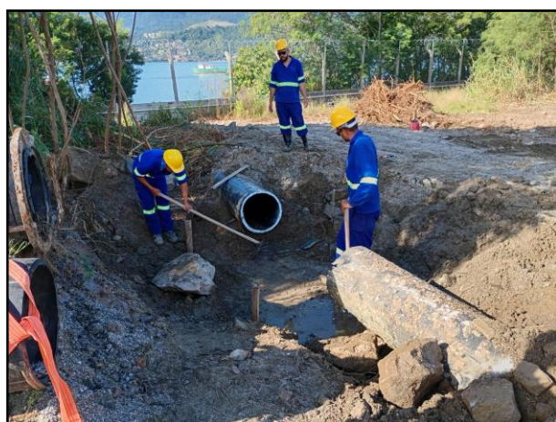
Foto 14: Processo de construção da caixa de passagem em alvenaria.
