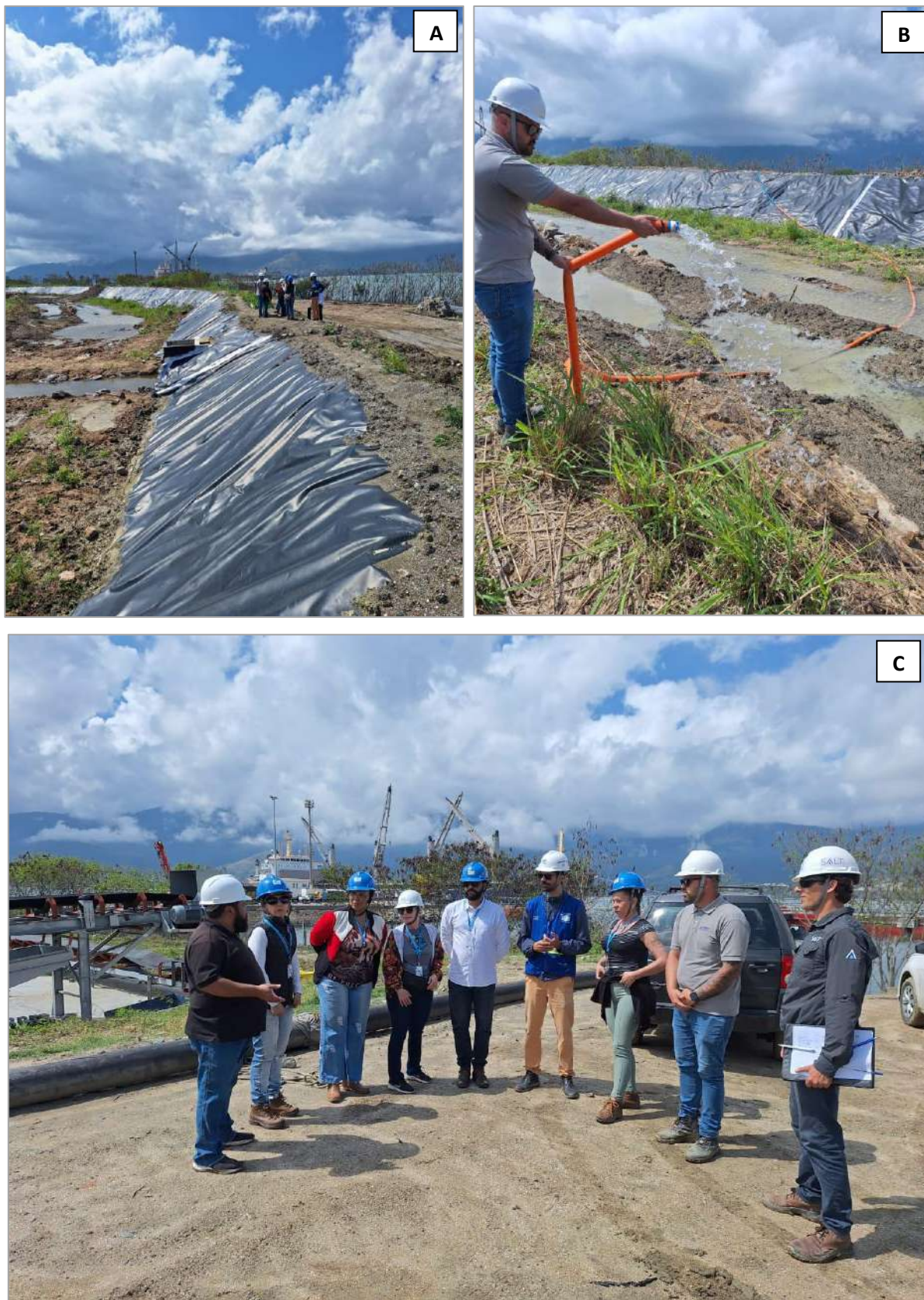
Figura 20 (A, B e C) - Registros fotográficos da visita técnica ao dique de contenção com a comunidade, realizada no dia 30 de agosto de 2025.
