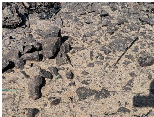
Figura 111 Cais. Deposição de resíduos de cevada no enrocamento.
