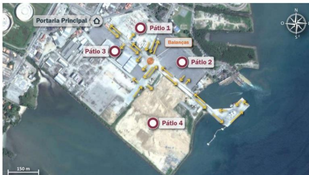
Figura 9 Pátios e Armazéns. Fonte PEI.
