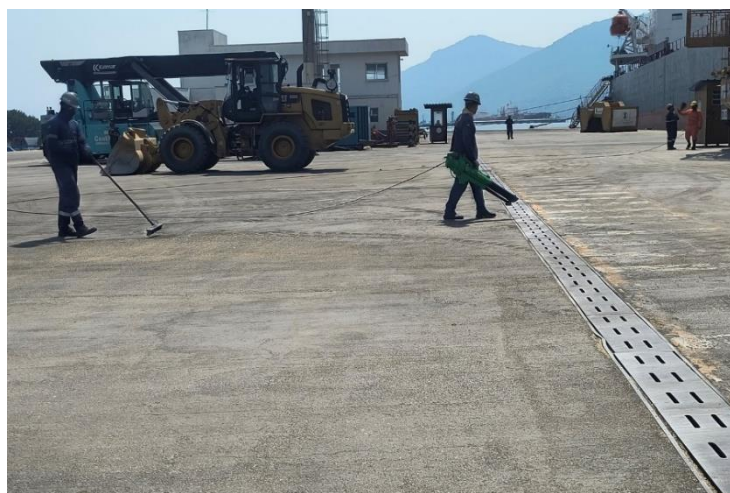
Figura 109 Cais. Limpeza de resíduos do descarregamento de carga de cevada.
