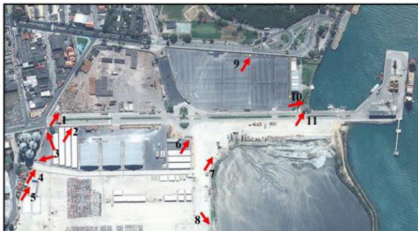
Figura 42 Termo de Referência SEI/GESP 0038333254 de 30/08/2024. Contratação do serviço de limpeza de 8 caixas SAO
