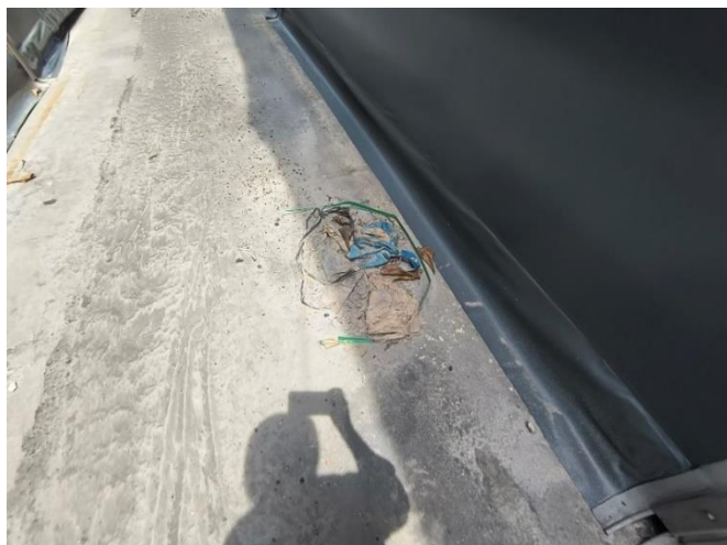
Figura 85 Pátio 2 resíduos de fita plástica no chão descarte incorreto. Não conformidade.
