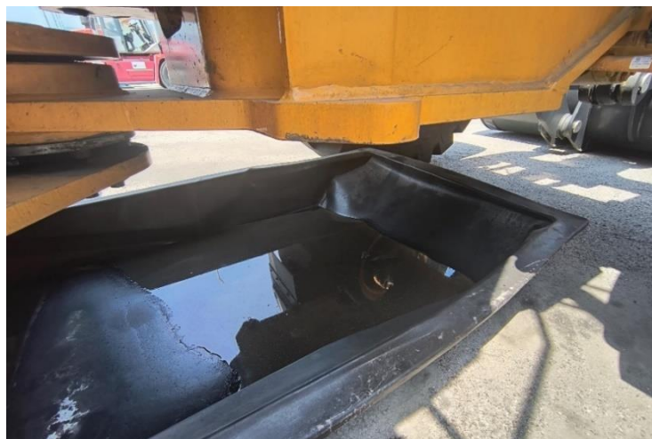
Figura 64 Pátio 3. Estacionamento de maquinário. Caixa plástica contentora com acúmulo de água,
