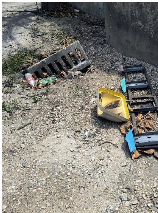
Figura 80 Pátio 1. Tampa de bueiro quebrada. Resíduos misturados no chão. Tampa de lixeira quebrada. . Falha na segregação na fonte e cumprimento dos procedimentos operacionais. Não conformidade.
