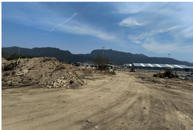
Figura 104 Pátio 4 (aterro) e Muro.
