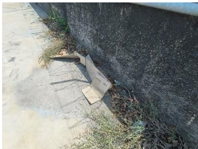
Figura 73 Pátio 1. Papelão em local inapropriado. Folhas, mato e falta de limpeza. Não Conformidade. Falha na segregação na fonte e cumprimento dos procedimentos operacionais. Não conformidade.
