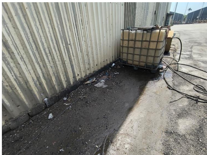
Figura 68 Pátio 3. Acúmulo de água no chão, lavagem de maquinário em local inadequado. Resíduos no chão. Não conformidade.
