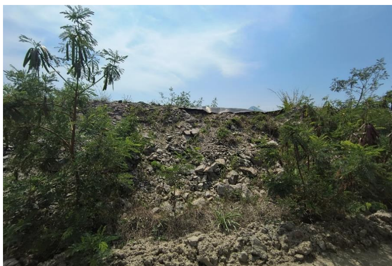
Figura 105 Pátio 4 (aterro) – manta geotextil em área de depósito de resíduos de dragagem.
