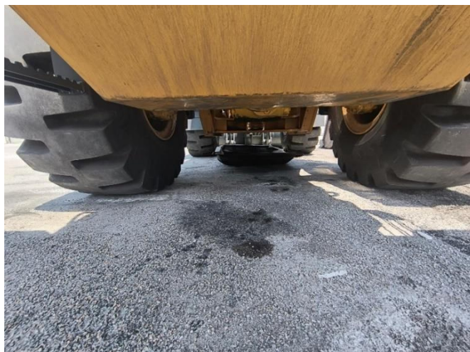
Figura 65 Pátio 3. Estacionamento de maquinário. Maquinário sem caixa de contenção para vazamento de óleo no piso.
