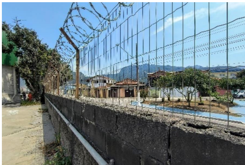
Figura 6 muro do Pátio 1 e vizinhança.
