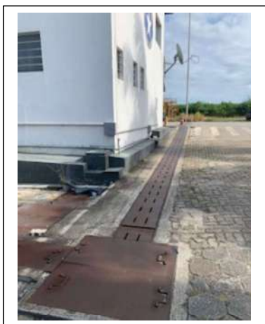
Canaleta de contenção de sedimentos presente na área do píer (acima)
