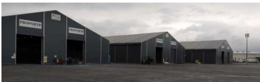
Pátio 1 e pátio 2, destinados a Proporto no Acondicionamento de Grãos
