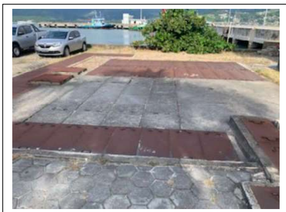
Canaleta de contenção de sedimentos presente na área do píer (acima)
