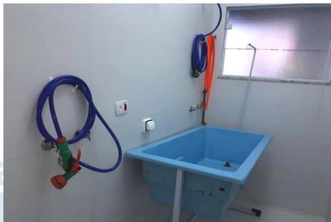
Sala de descontaminação
