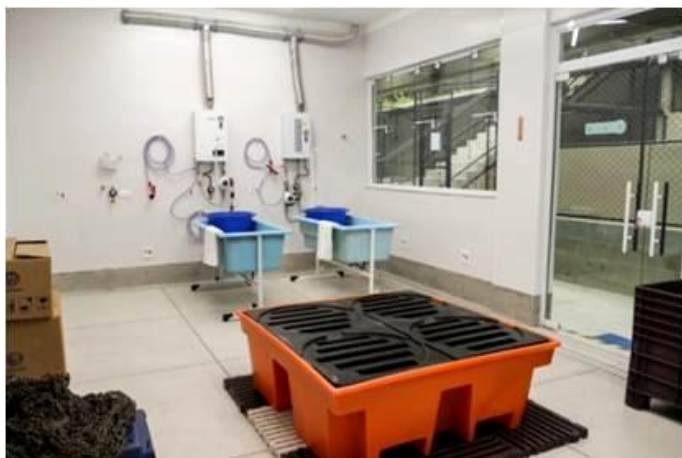
Sala de descontaminação
