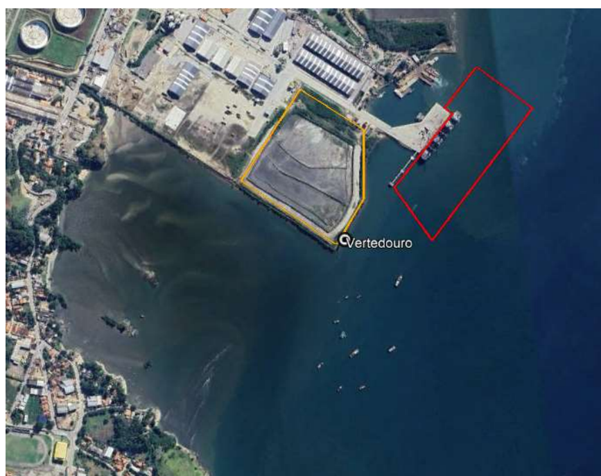
Figura 3.4.3.3-1: Área de sobrevoo com drone, incluindo área de operação da draga (polígono de dragagem em vermelho), da área do vertedouro e ao redor do dique de contenção (polígono em laranja).
